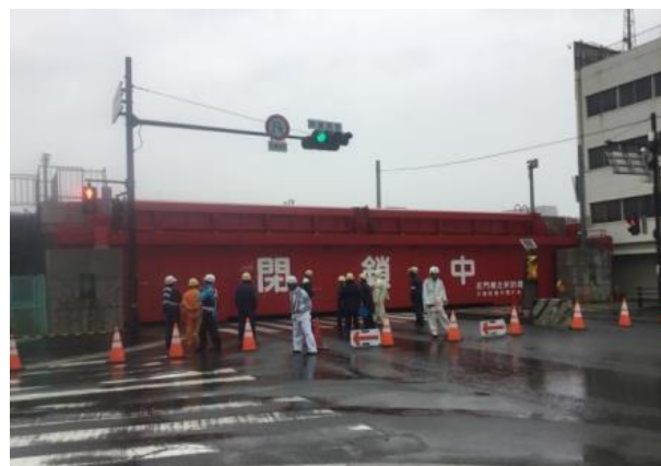
平成30年台風21号 左門橋左岸 左門殿川
