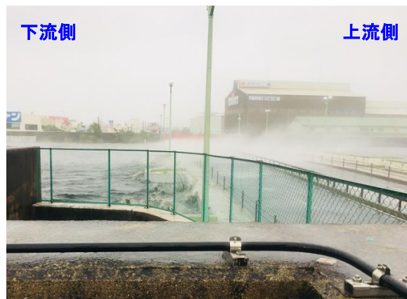
平成30年台風21号 国道2号（左門橋）左門殿川
