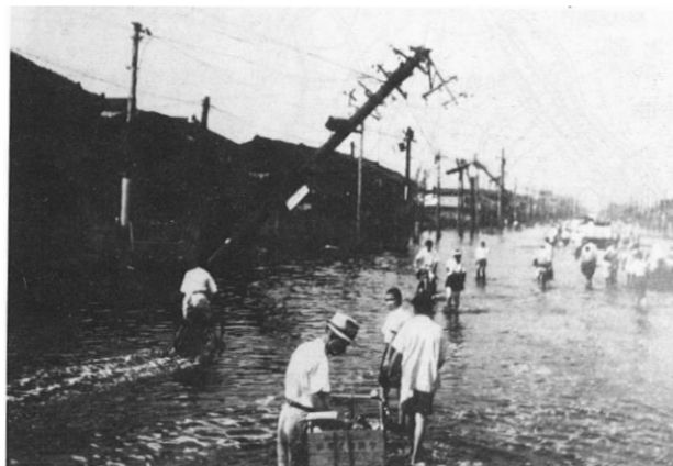
ジェーン台風 国道2号付近
