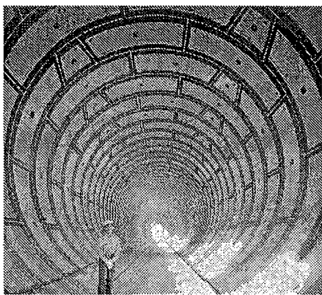
寝屋川北部地下河川(古川調節池)
