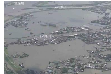
筑後川水系筑後川 （福岡県久留米市）
