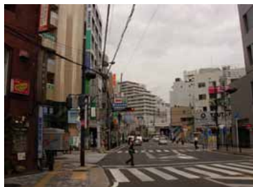
電線類地中化前
