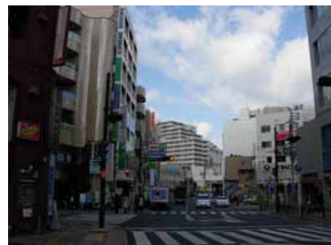
電線類地中化後
