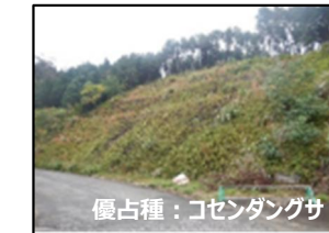
安威工区（H25～H26施工）
