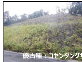
生保工区（H26～H27施工）
