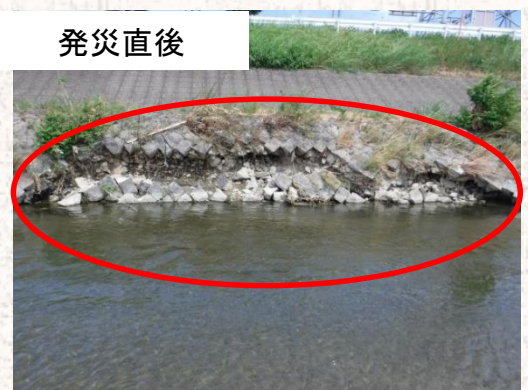
【安威川】太田橋下流左岸 護岸崩壊L=15m
