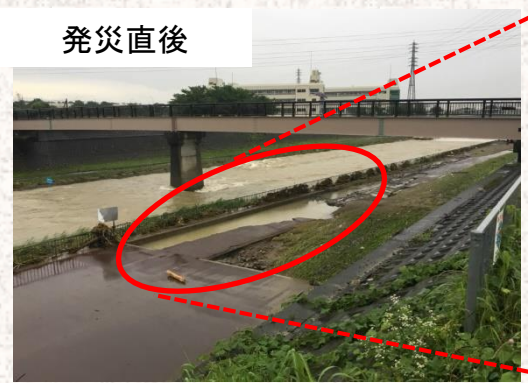
【安威川】太田橋下流左岸 護岸崩壊L=15m
