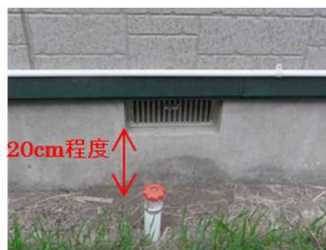
一般的な床下換気孔の例
