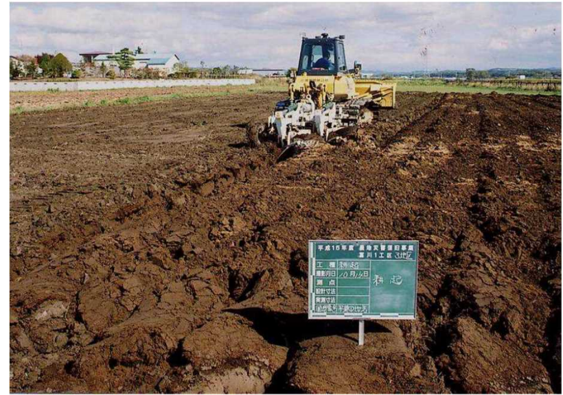
湛水によって荒らされた農地を 作付けに間に合わせるための耕起
