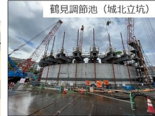
鶴見調節池 (城北立坑)
