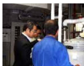
設備の運転管理状況の診断
