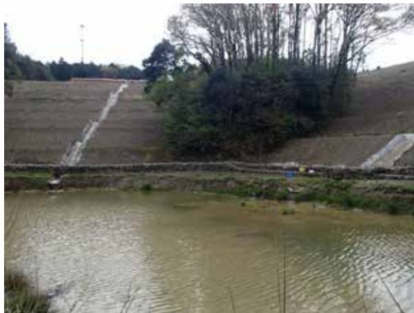
建設残土搬入地点
