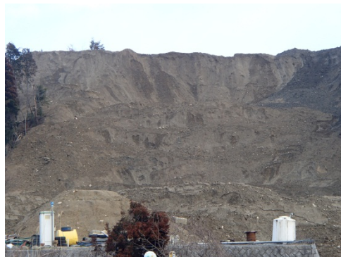
残土崩落現場
