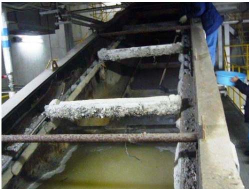
<灰出しコンベアから主灰を採取する様子>
