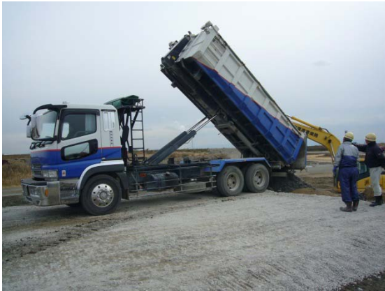
<主灰の埋め立ての様子>
