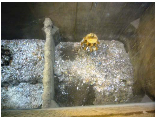
<ごみピットの様子>
