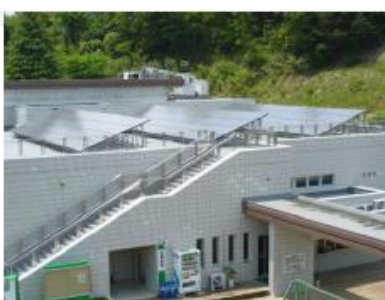
太陽光発電システム
