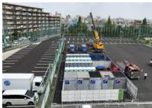
仮設便所、駐車場舗装（ラグビー場北側）
