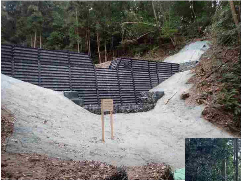
①治山ダム全景
