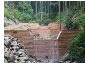
小規模治山ダムの階段状配置
