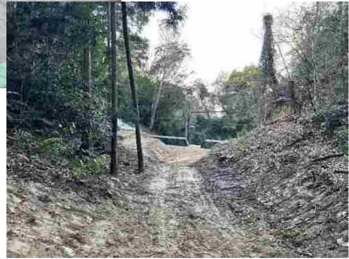
②流木の危険がある木を伐採
