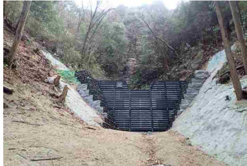
①治山ダム全景
