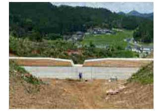
堆砂容量のある治山ダムの設置
