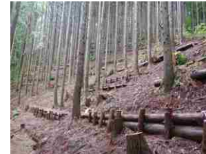
本数調整伐と筋工の施工
