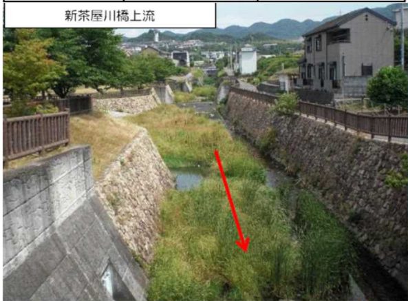
◇現況河道（茶屋川） 時間雨量80ミリ程度の降雨を対象とした改修完了
