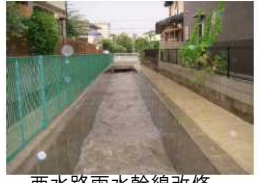
西水路雨水幹線改修
