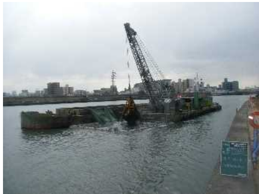
神崎川河床掘削工事
