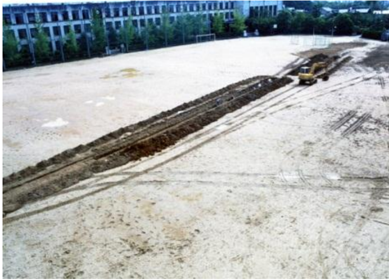
■ 試掘調査状況（南西から）
