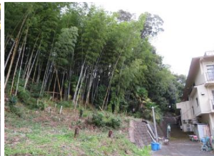
斜面と保全対象の状況
