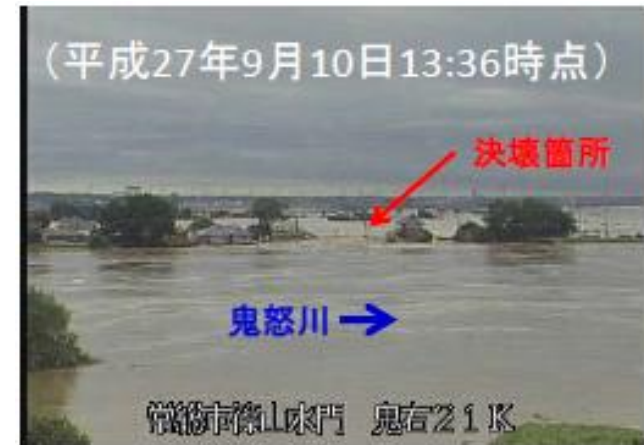
被災状況(対岸より撮影)
