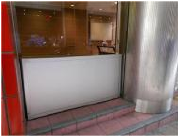
止水板の設置事例
