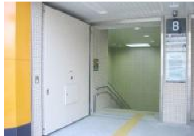
止水扉の設置事例
