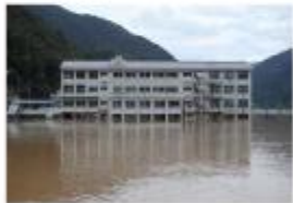
H26. 8 避難所2階の浸水(徳島県)
