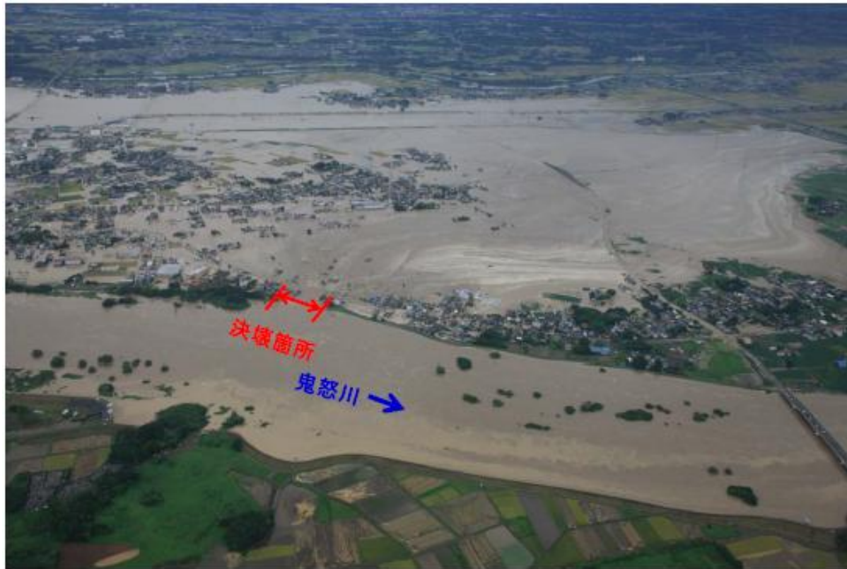
被災状況(全景写真)
