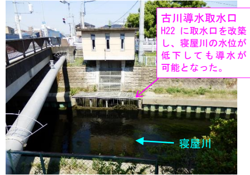
図 5.8 古川導水路の呑口部
