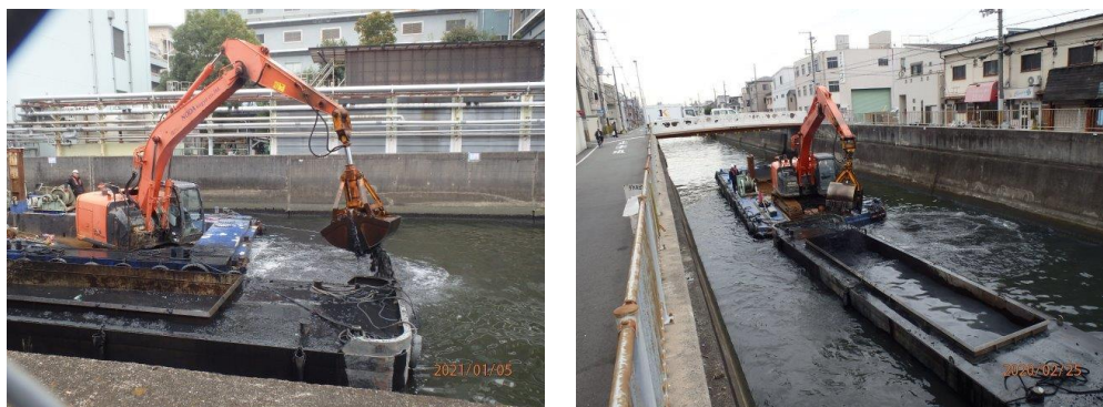
図 5.20 底泥浚渫の状況(平野川)
