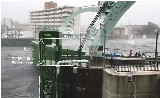
▲平成30年台風第21号到来時の木津川水門
