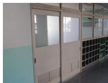
拠点教室の廊下側の出入口
