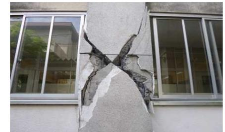
耐震化未完了の建物が大規模地震で甚大な被害を受けた例
