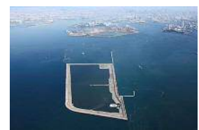
大阪沖処分場
