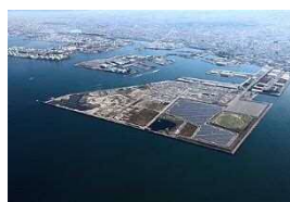
泉大津沖処分場
