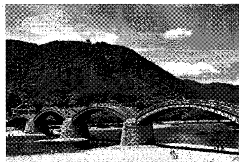
岩国市 錦帯橋
