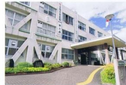
南館校舎・正門
