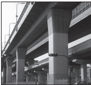
阪神高速道路の橋脚
