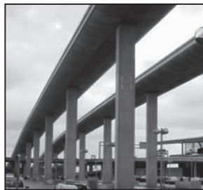
空港アクセス道路の橋脚
