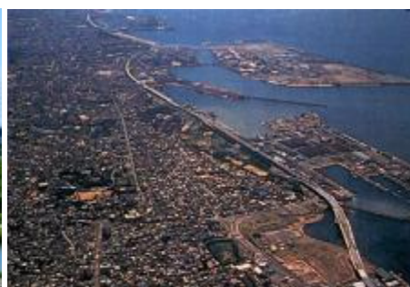
広域幹線道路における景観づくり
