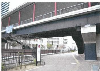
目立たない色彩を用いることで歩行者目線に配慮した橋梁（龍華町二丁目）
