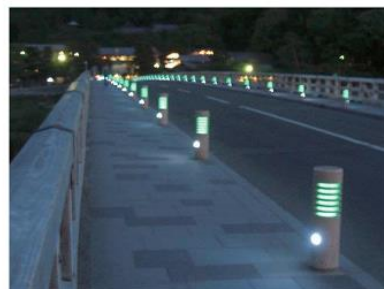
▲景観への影響に配慮しつつ安全性を確保するため、背の低い照明灯を用いている【3】(京都市)
