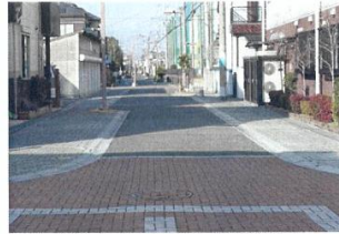
線形を工夫することで安全面に配慮した車道（刑部三丁目）
