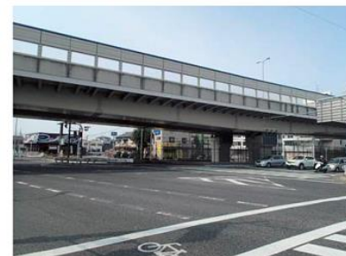
▲色彩を明るいプレーで統一し、景観的な分断要素とならないようにしている【③】（藤井寺市）
