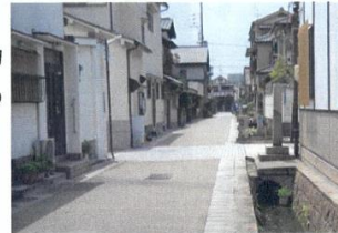
無電柱化された道路（久宝寺三丁目）
