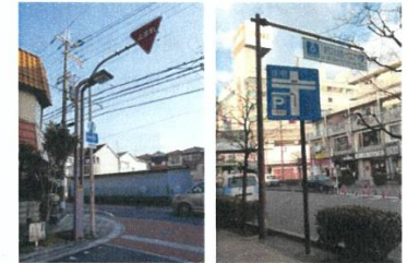
支柱を目立たない色彩とした道路標識 左) 刑部三丁目 右) 東本町三丁目
