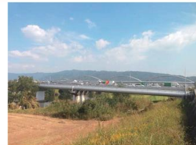
▲ 素材色を用いることで水辺景観に違和感なく溶け込んでいる【1】（藤井寺市）
