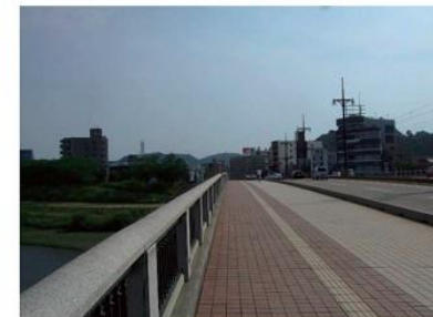
▲ 茶系の舗装により、橋全体が落ち着いた雰囲気となっている【3】【4】（福井市）
