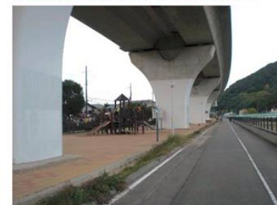
▲ 橋脚の形状を工夫することで高架下の空間に開放感がある【③】（川西市）
