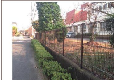
▲フェンスの色彩をダークブラウンとすることで敷地周辺の緑と調和している【1】(藤井寺市)
