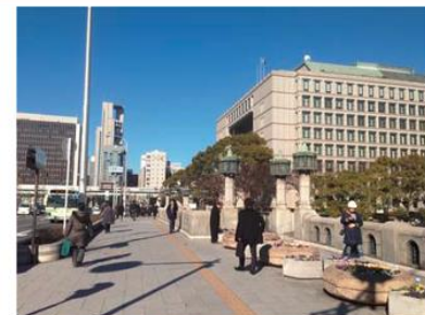
▲落ち着いた色彩で周囲の景観との調和を図りつつ橋のシンボル性を高めている【②】（大阪市）
