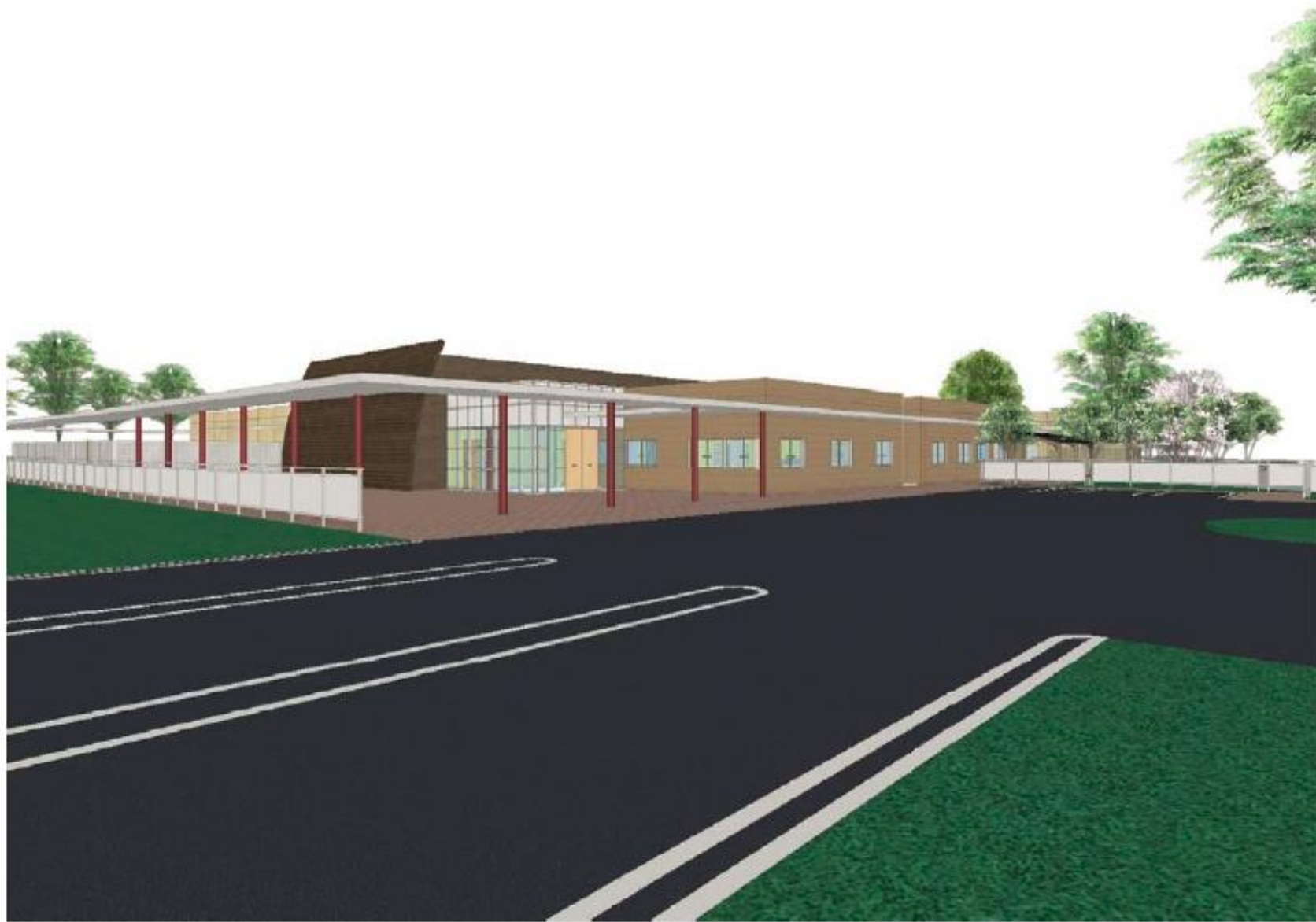
西側エントランス
