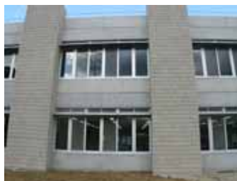
本館棟外部設備シャフト
