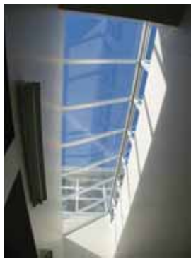
実習棟廊下 トップライト
