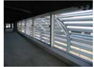
実習棟換気窓
