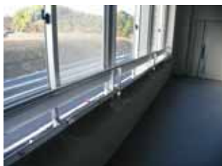
教室 窓下換気小窓
