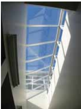
実習棟廊下 トップライト
