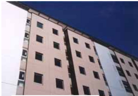
太陽光電池を組み込んだ庇
