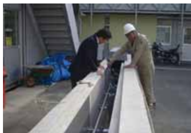
床上配管ピットのモックアップ
