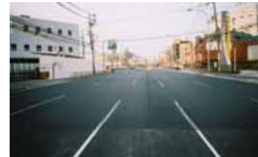
透水性舗装(アスファルト方式) 京都守口線(大阪府)
