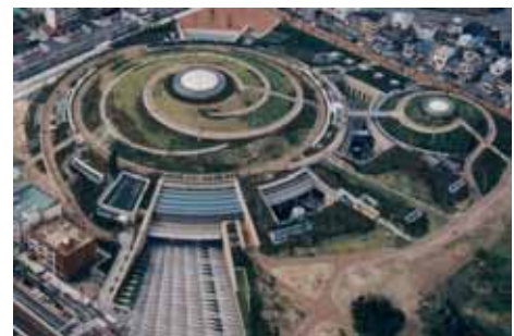
雨水利用施設などで人工地盤に水循環を再生 大阪市中央体育館
