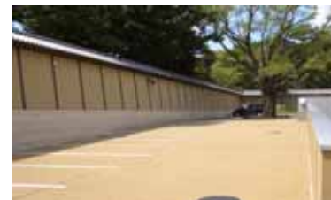
透水性舗装(樹脂方式) 京都御所迎賓館(京都府)
