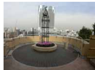
保水・揚水性舗装(インターロッキング方式) なんばパークス
