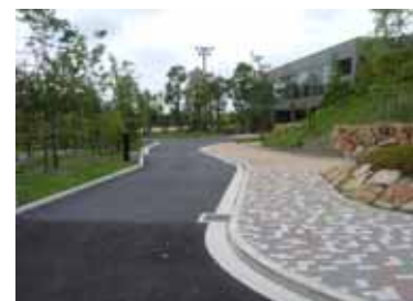
保水・揚水性舗装(アスファルト方式) トヨタ夢の住宅PAPI(愛知県)
