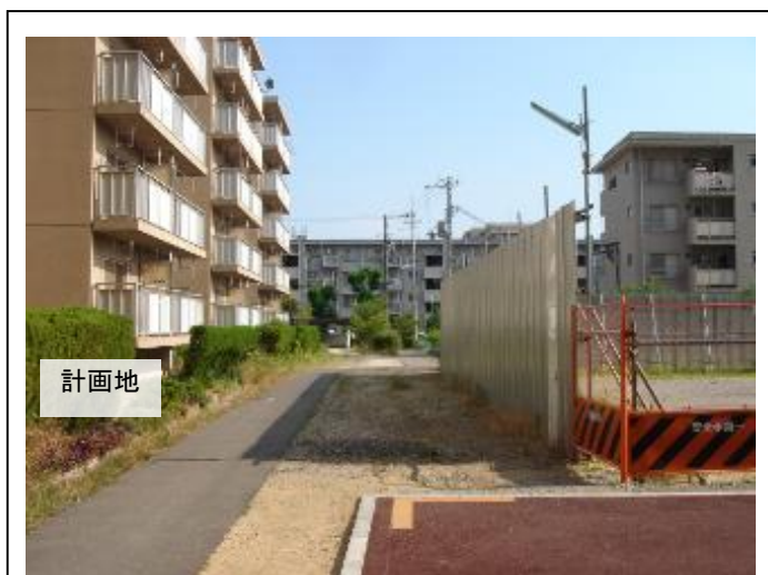
③ 計画地から南方向（既存住宅の西側）
