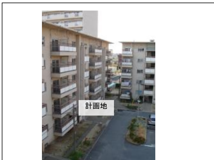
② 計画地（南東撤去予定の住棟5階より）
