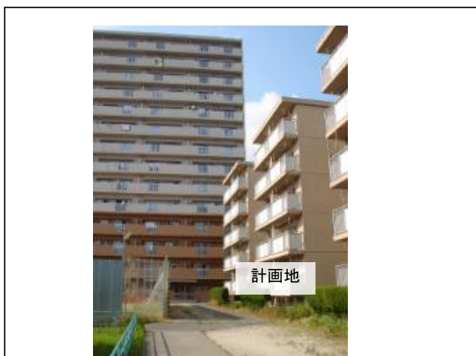
⑤ 計画地（南より）左奥はI期工事完成住宅（B棟）
