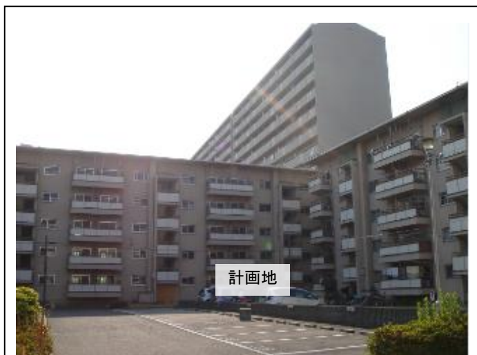
① 計画地（南東より）背後はI期工事完成住宅（B棟）
