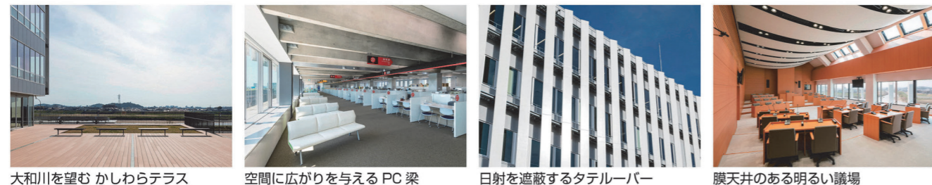
大和川を望む かしわらテラス 空間に広がりを与える PC 梁 日射を遮蔽するタテルーバー 膜天井のある明るい議場
