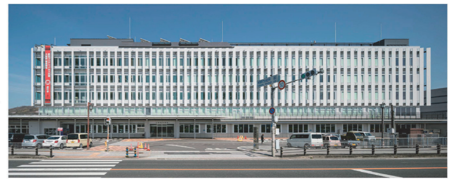
西面外観：低層部は水平庇、高層部はタテルーバー
