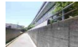
堺（出島）漁港の防潮堤
