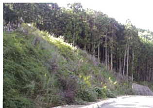
マザーソイル工法 (現地の表土を活用した法面吹付工法)
