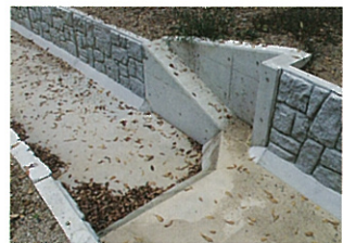
小動物に配慮したはい上がり水路
