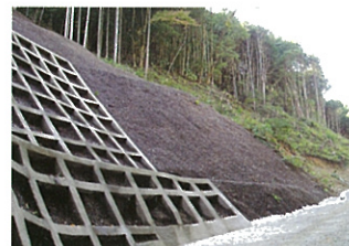
植生誘導吹付工 (現地の伐採木のチップを活用した吹付工法)
