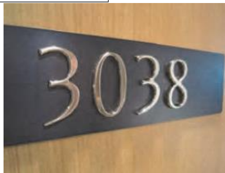
室番号の浮き彫り表示の例
