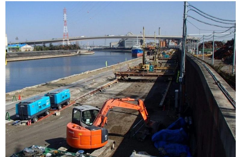
施工中(地盤改良工)
