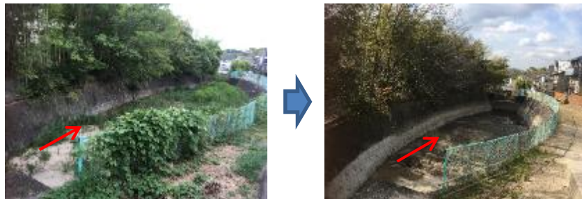
土生川（砂溜工）
