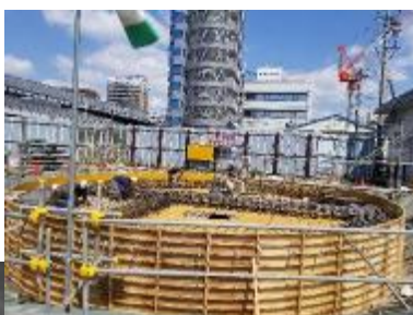
松生立坑 頂版・建築・上面
