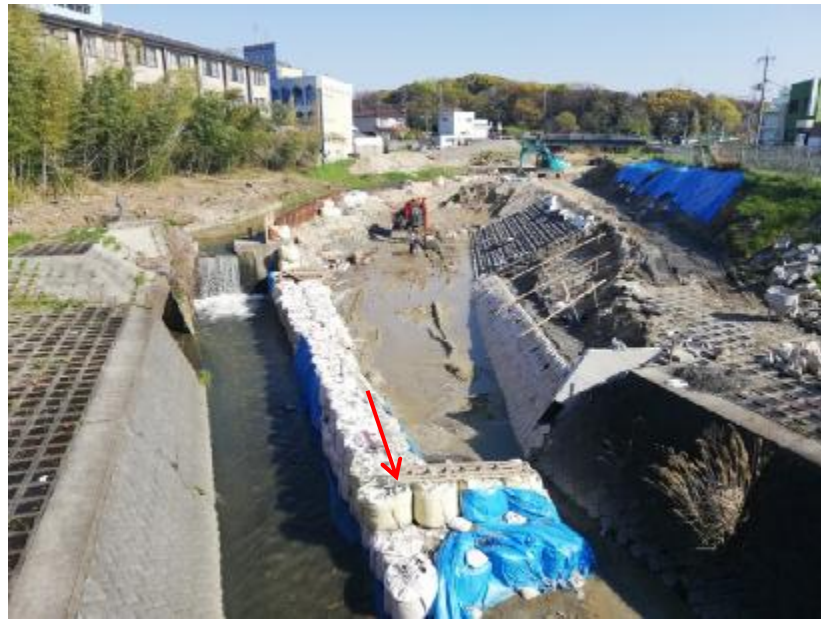
穂谷川改修工事（80mm対策）
