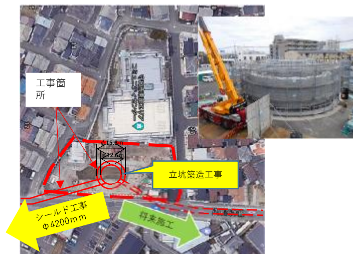
発進立坑（守口市大久保1丁目）
