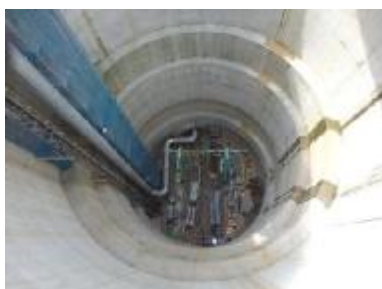
守口立坑 頂版など
