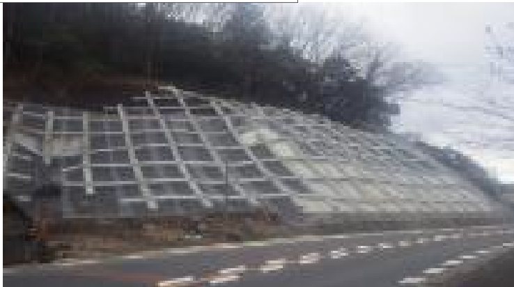
道路のり面对策
