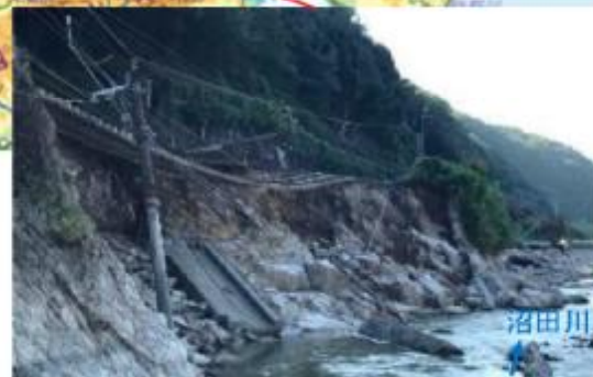
山陽本線本郷駅～河内駅(広島県三原市)
