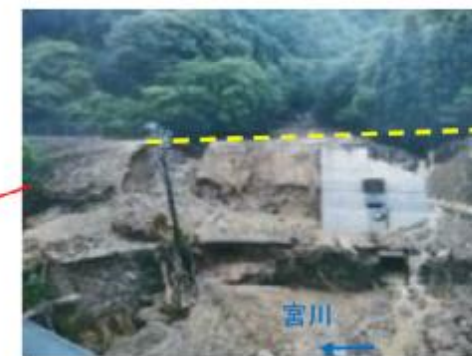
高山本線板上駅～打保駅(岐阜県飛騨市)
