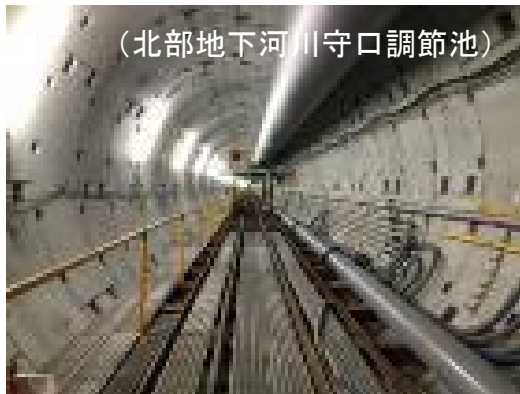
地下河川・流域調節池整備
