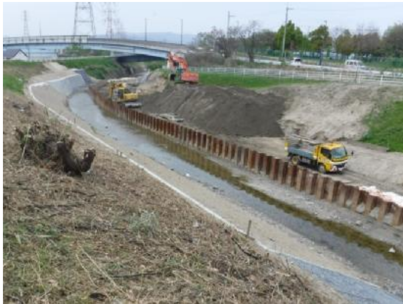
穂谷川改修工事（80mm対策）
