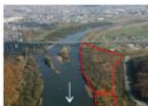
・河道掘削や樹木伐採
