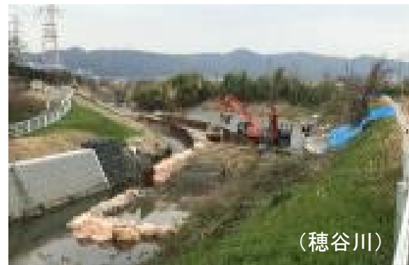
河川改良(河道掘削・河道内樹木伐採等)
