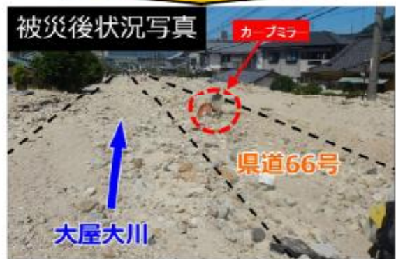
呉市天応西条地区における被害状況
