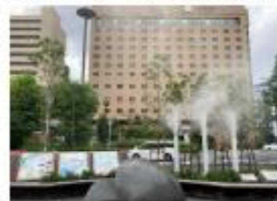
京阪・守口市駅 (R3年度竣工)
