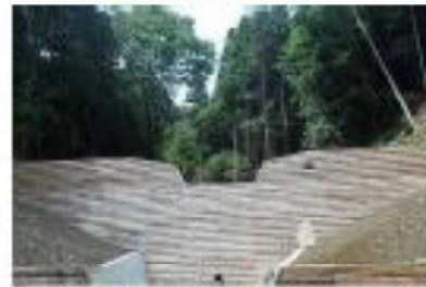
茨木市泉原地区 (R4年度竣工)
