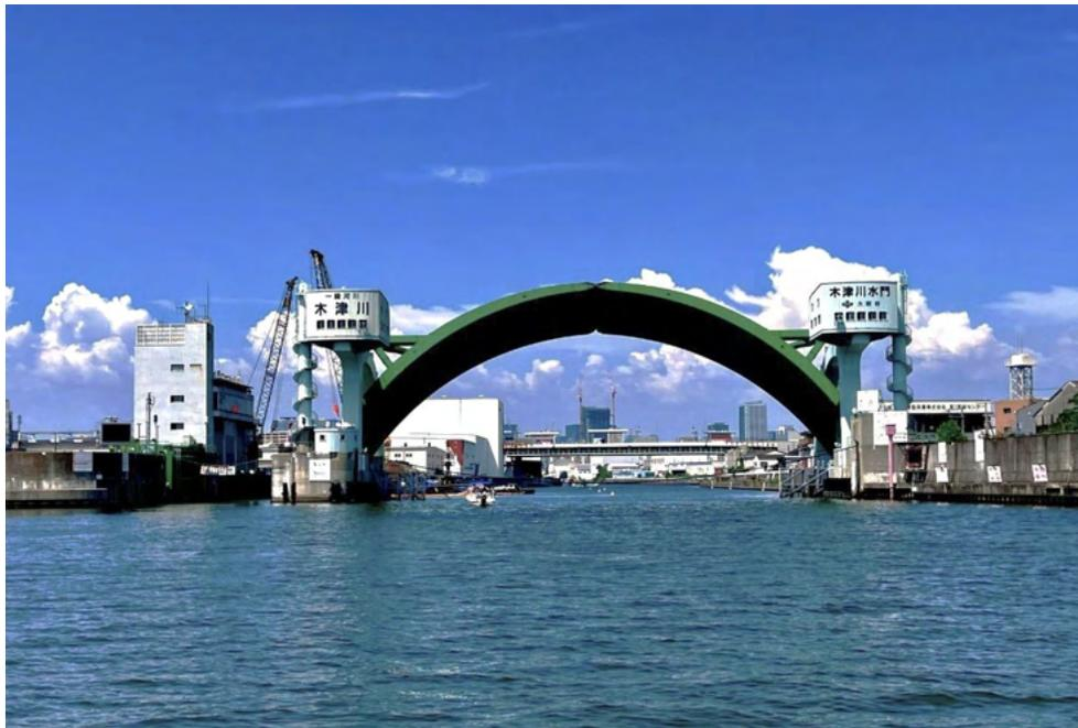
西大阪地域を流れる安治川、尻無川、木津川の河口部には、高潮による被害から市街地を守るために、国内では珍しいアーチ形の水門が建設されています。中でも木津川水門は、アーチ型の鋼製ゲートの緑色がとても映え、構造物自体の巨大さにも圧倒されます。津波にも耐えうる新たな水門への更新が予定されており、その姿を目にするのもあとわずかかもしれません。
