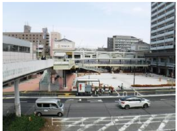
駅東側の再整備
