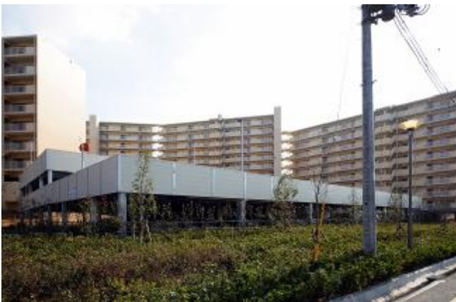
立体駐車場横の緑化部分（OPH南千里津雲台）
