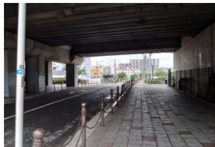
国道高架下の暗い歩道
