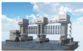
新木津川水門完成イメージ 出典：大阪府
