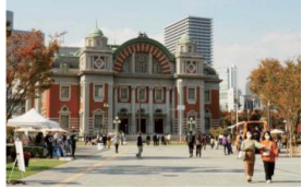
中之島通の 歩行者空間整備 提供：大阪市
