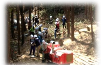
チップ舗装作業
